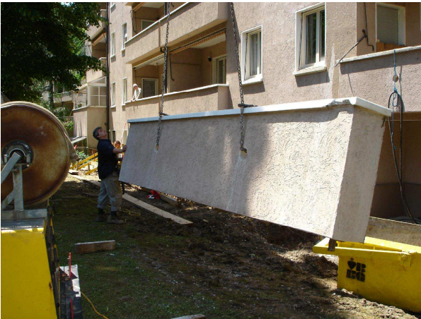
Abbruch der alten Balkone an der Sierenzerstrasse
