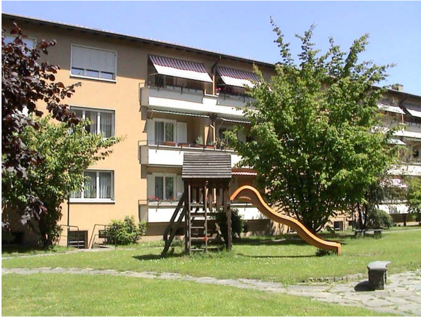
Gartenseite der von der WG Chrischona sanierten Liegenschaften Magdenstrasse 2-6, Basel.
