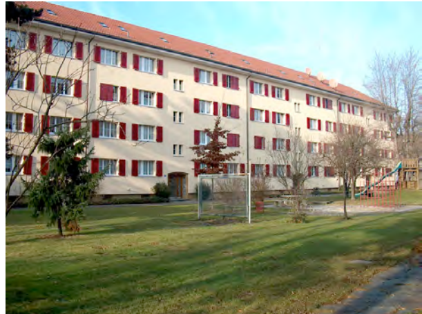
Dach und Fassaden optimal isoliert. Dies trug zur massiven Senkung der Nebenkosten bei.
